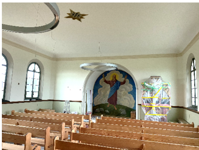
Bild: Stand der Arbeiten 10. Dezember
